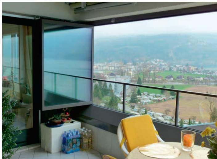
Die Elemente werden am Schienenende gestapelt. Jedes Element kann nach Belieben gedreht werden, was ein einfaches Reinigen ermöglicht.
