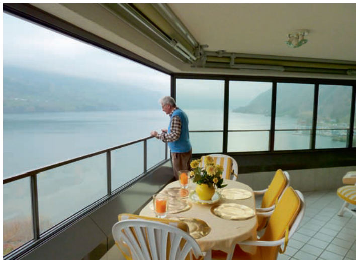
Die Schiebe-Dreh-Verglasungen lassen sich auf einer Linie schieben und vollflächig öffnen.
